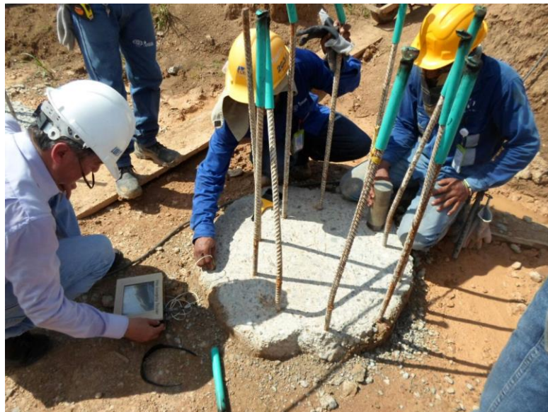
Figura 3. Instalación del acelerómetro en la cabeza de un pilote.
